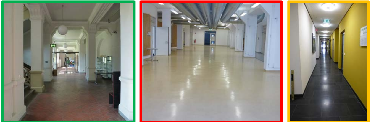
Abbildung 21: links - Flur Standort Schlüterstraße / mittig - Flur Haus 5 Campus Altonaer Straße / rechts - Flur Haus 9 Campus Altonaer Straße
