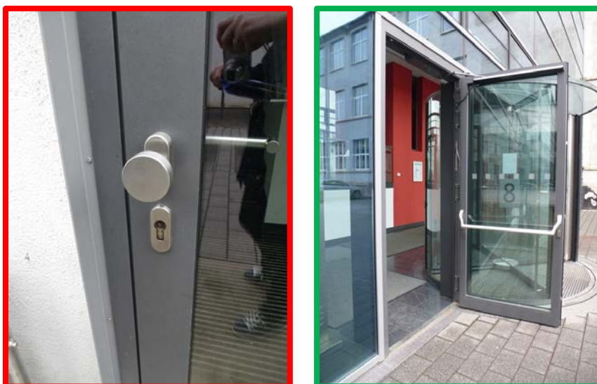
Abbildung 12: links - Türknauf / rechts - waagerechter Bügel
