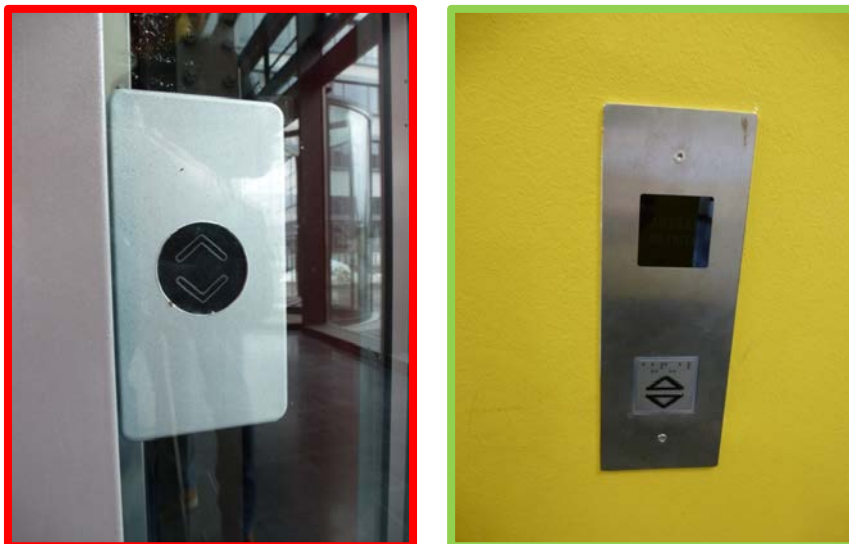
Abbildung 18: links - Haus 8, keine visuell und taktil kontrastierende Gestaltung / rechts - Haus 9, visuell und taktil kontrastierende Gestaltung
