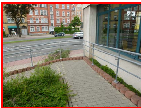
Abbildung 15: Rampen: links - Leipziger Straße - Handlauf beidseitig; Profil optimierungsfähig; Längsneigung \leq 3,6 % / rechts - Steinplatz - einseitiger Handlauf; Längsneigung \leq 7,7 % / Querneigung \leq 4,4 %
