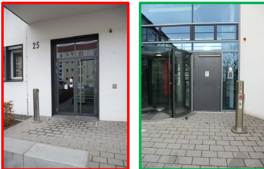
Abbildung 11: links - Eingang Haus 7 - unzureichende Türbreite / rechts - Eingang Haus 8 - ausreichende Türbreite
