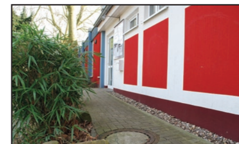
Mit dieser Rampe kommen Kids und Teens barrierefrei in das Jugendzentrum an der Kaiserstraße. Foto: Stadt Wetter (Ruhr)
