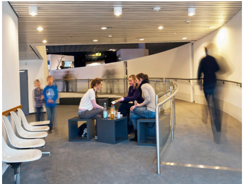
↑ LWL-Museum für Naturkunde in Münster: Einbau einer Rampe zur barrierefreien Erschließung der WC- und Wartebereiche
