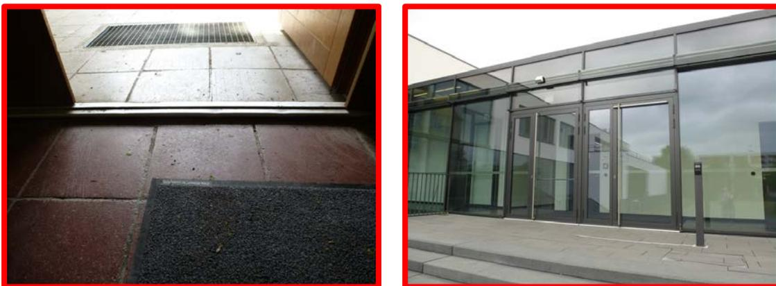
Abbildung 14: links - Türschwelle im Bestandsbau (Eingang 2) / rechts - unzureichende Markierung der Glasflächen (und Treppenstufenkanten)
