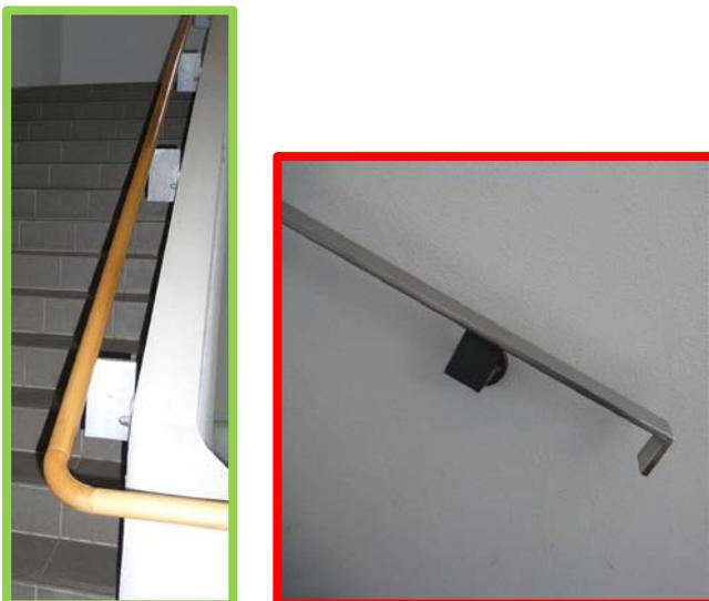
Abbildung 17: links - Handlauf in Rundprofil (greifgünstig) / gerader Treppenlauf / rechts - Handlauf in eckigem Profil (greifungünstig)
